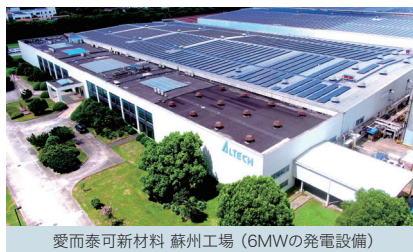
愛而泰可新材料 蘇州工場 (6MWの発電設備)
