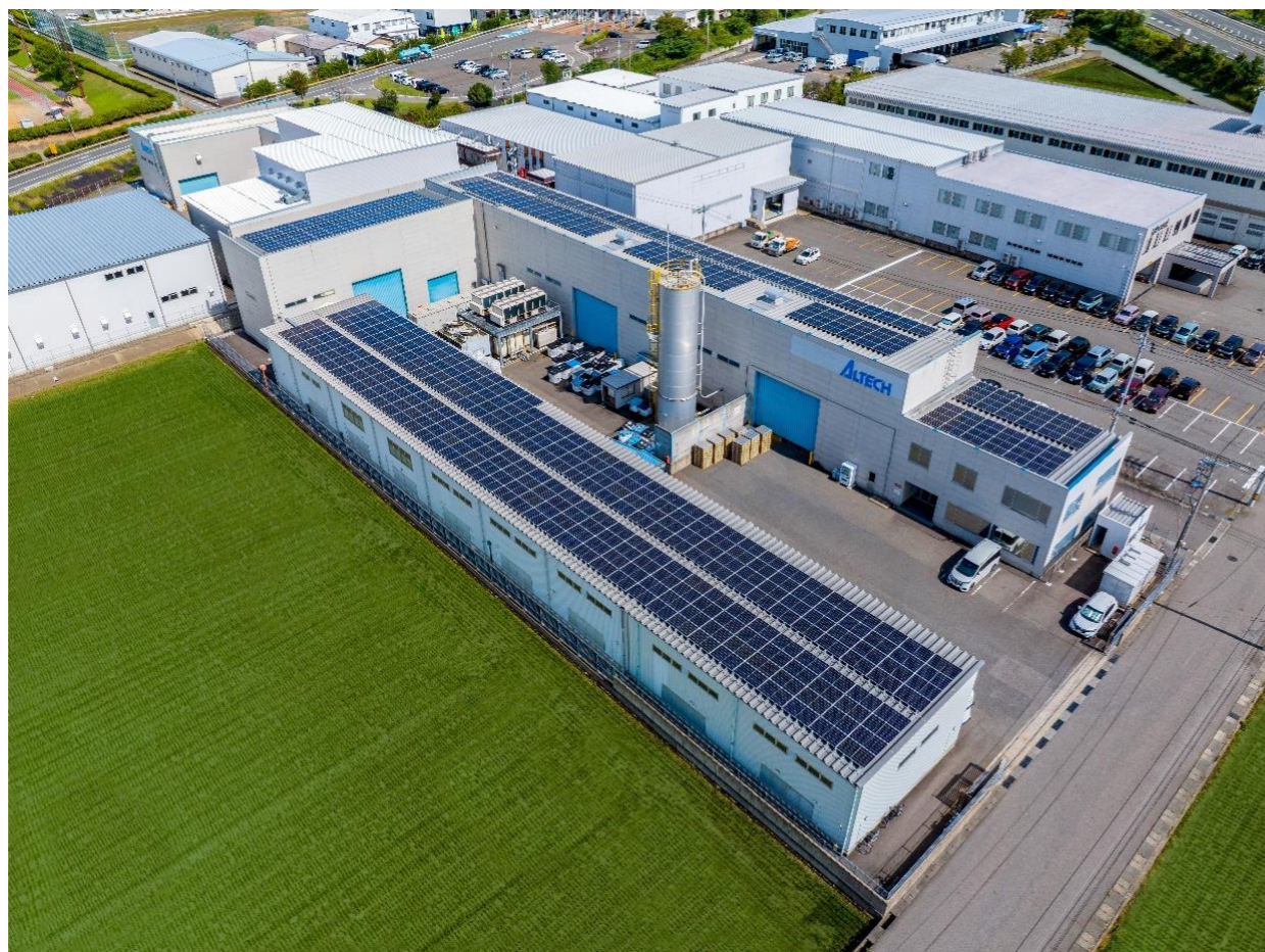
アルテック新材料（福井）の工場屋根の太陽光発電設備
